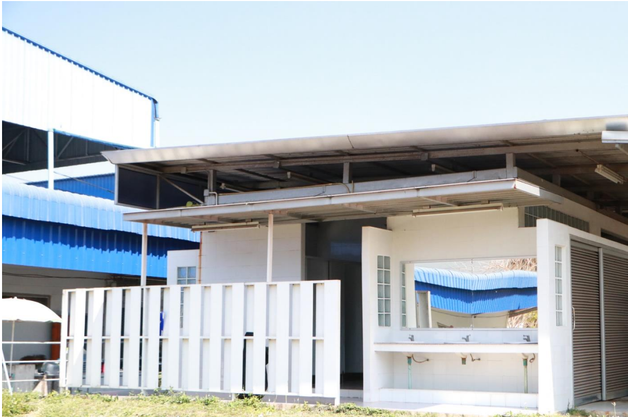
15. ห้องน้ำ - ห้องส้วม
